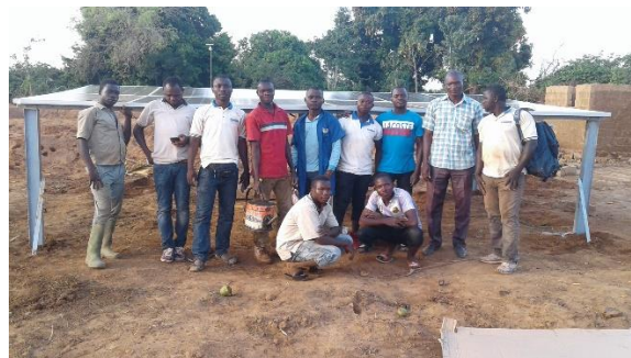
Die Pumpeninstallation ist fertig
